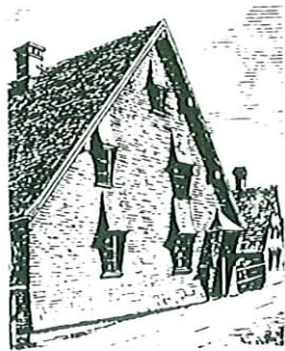
Abbildung 15. Hinterseite; Schindelschirm mit Fensterschutz (Speicher)
