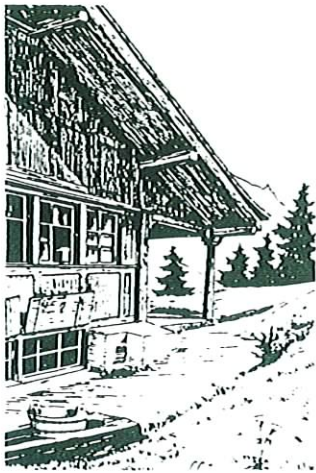
Abbildung 22. Freitreppe unter Vordach mit Ecksäule (Teufen, im Töbeli)
